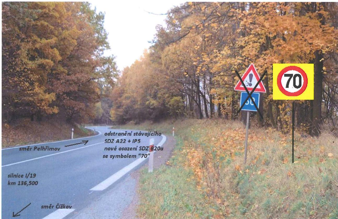
odstranění stávajícího dopravního SDZ A 22 + IP5 , osazené nové SDZ B20a se symbolem „70“ na retroreflexním podkladu
